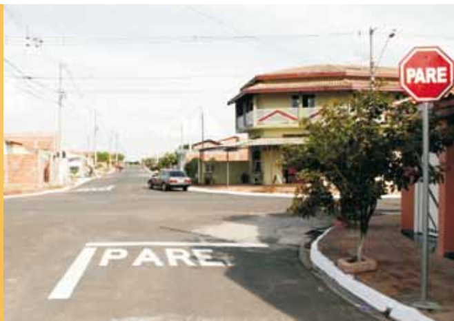
Com asfalto novo e sinalizado, população do bairro deixou de penar com barro e poeira
