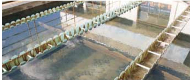
Melhorias no decantador da ETA do Bela Vista permitiu economia de 100.000 litros por dia
