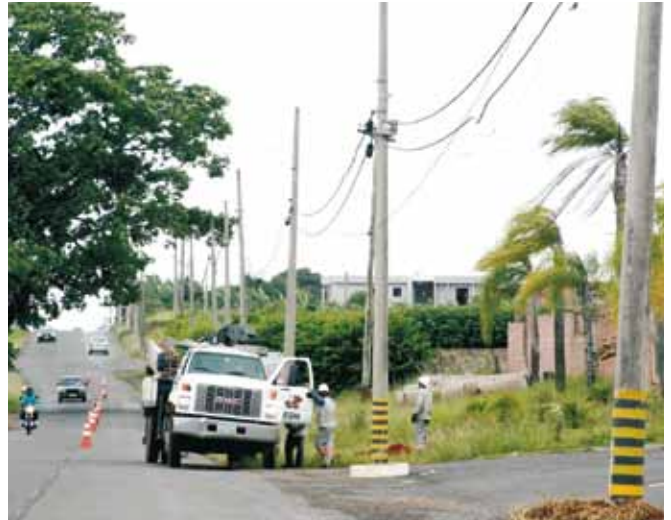
Rodolfo Kivitz, que já era iluminada no trecho urbano, recebe lâmpadas também em trecho rural
