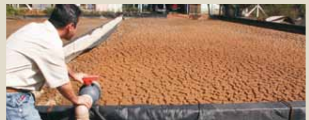
Sistema de secagem do lodo foi todo desenvolvido pela própria equipe técnica da Coden
