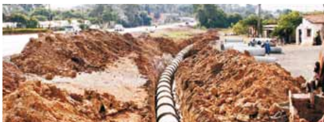
Urbanização: bairro ganhou guias, sarjetas, galerias de águas da chuva e pedras
